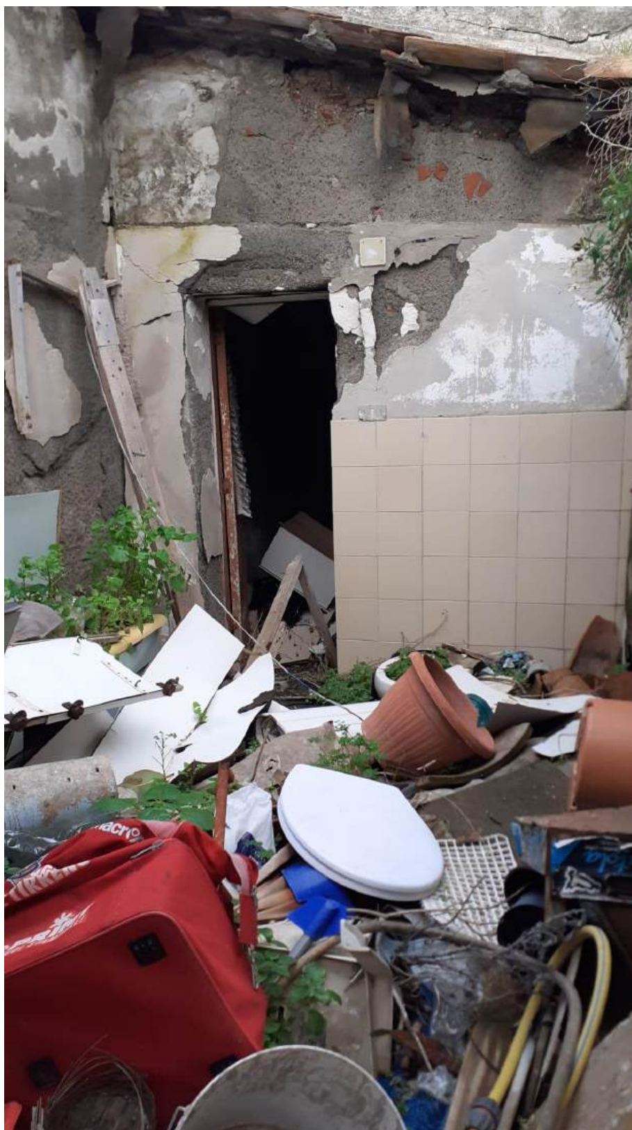
Foto 1 Accesso al fabbricato particella 46 lato ovest
